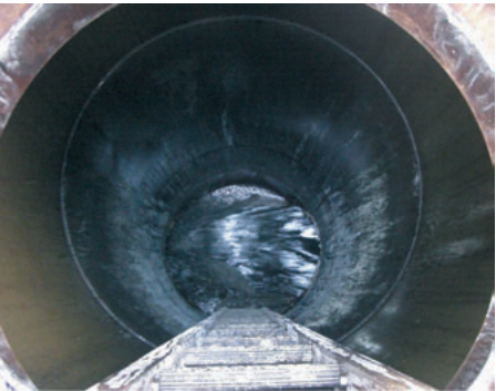
通過マンホール
