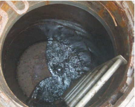
合流マンホール
