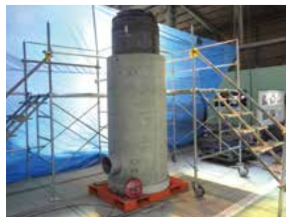
施工完了状況
