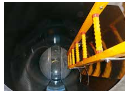
更生後のマンホール内面状況
