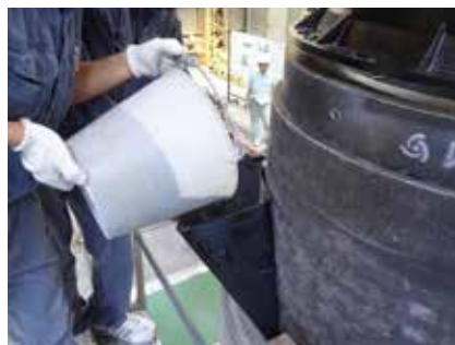
グラウト材充填状況
