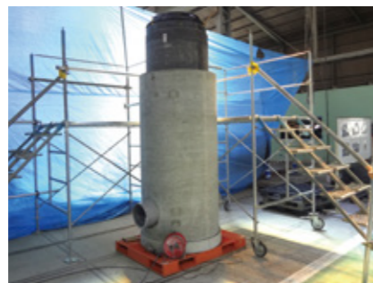
施工完了状況
