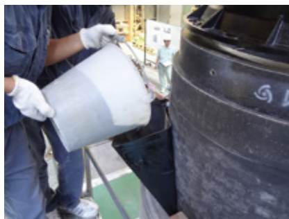
グラウト材充填状況
