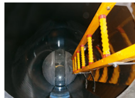
更生後のマンホール内面状況
